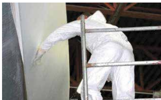
Poista pöly puhtailla rievuilla, jotka on kostutettu puhtaassa vedessä. Älä koskaan käytä liuotinta. AQUASTRIP-aineen käyttö mahdollistaa useiden kiinnittymisenestomaalikerrosten poistamisen.
